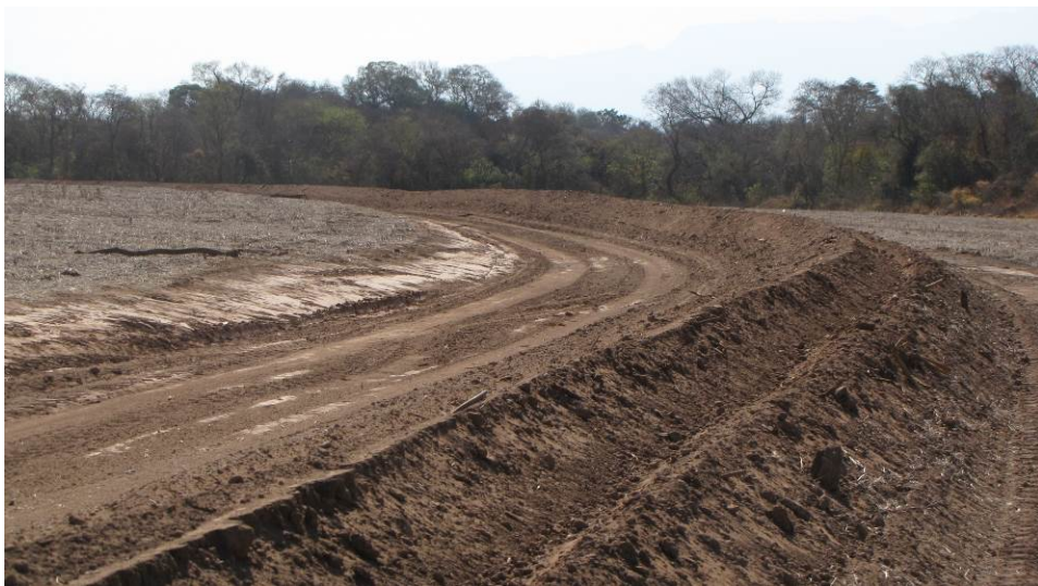
Típica obra de manejo de excedentes hídricos, que solo podría ser necesario en unción del funcionamiento del campo
